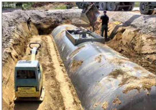
Установка подземного резервуара системы автономного газоснабжения LPG/SNG
